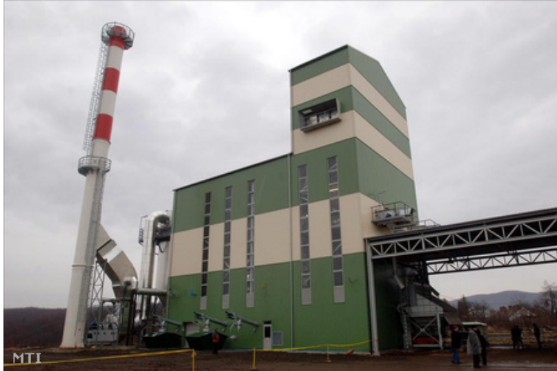
18. ábra Komlói Fűtőerőmű Zrt. biomassza tüzelésű blokkja
