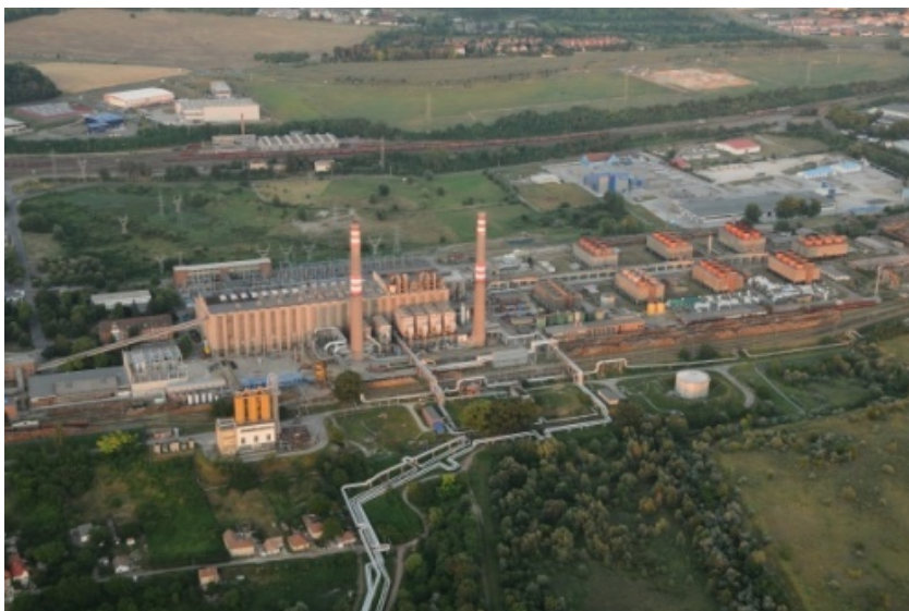
13. ábra Az épülő Pécsi fűtőerőmű biomassza blokkja I. -Dalkia Energia, Pannon Power
