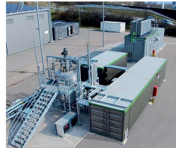
Audi e-gas üzem (Wertle, Németország) 6 MW el , alkáli elektrolízis, katalitikus metanizáció
