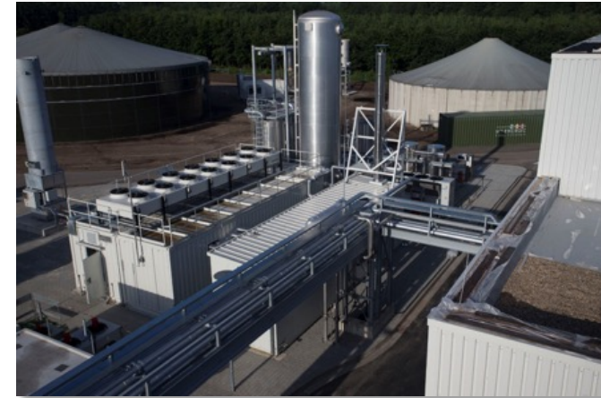
Audi e-gas üzem (Wertle, Németország) 6 MW el , alkáli elektrolízis, katalitikus metanizáció
