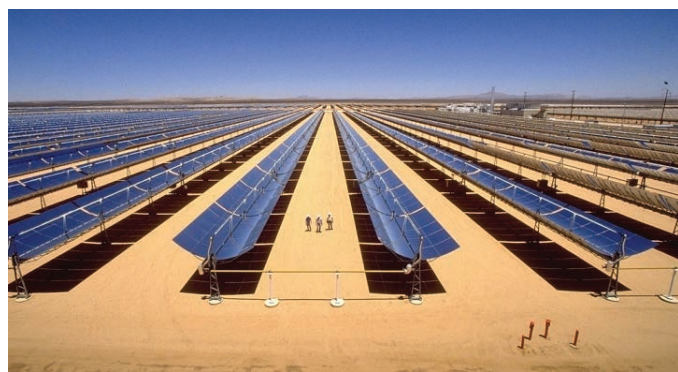
7. ábra. Egy naphőerőmű parabolacsatorna-rendszere
