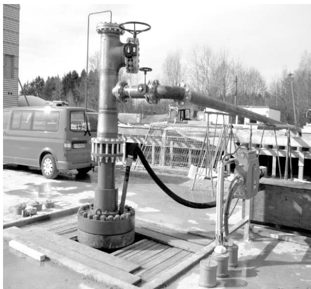
3. ábra. Decentrikus, magasnyomású hévíztermelő kútfej és nagynyomású, zárt hévízvezeték, építés közben
