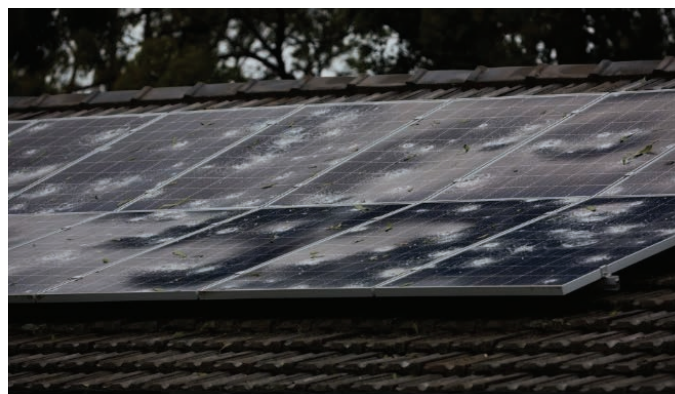
3. kép. A 2017-es Maria hurrikánban megsérült Puerto Rico-i napelem park és jégeső okozta károsodások Sidney (Ausztrália) városában
