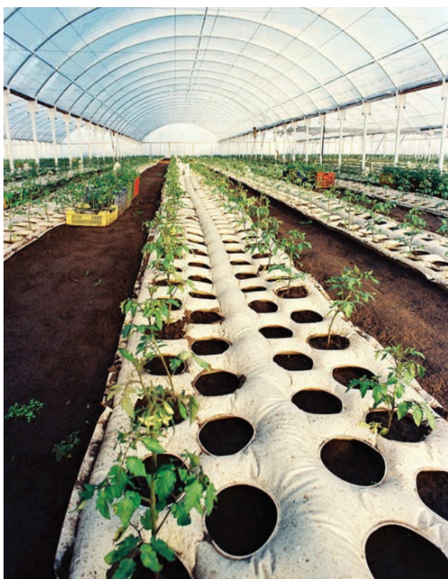
1. kép. Fűtőmatracos növényházi fűtési rendszer [5]
