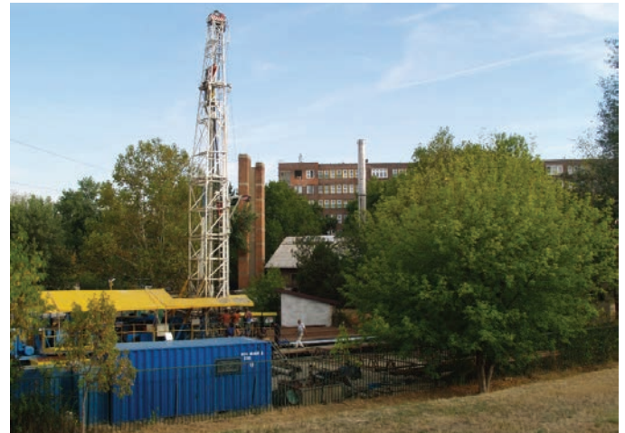
8. kép. A visszasajtoló kút fúrása (2012.09.11.), háttérben a kórház épülete
