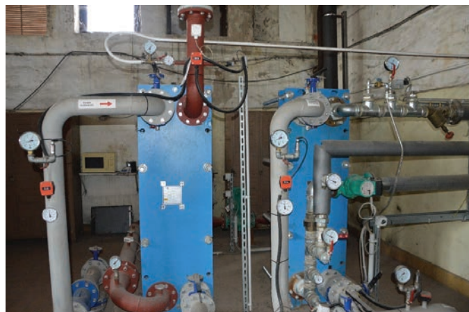
5. kép. A szűrt termálvíz lemezes hőcserélőn adja át a hőjét
