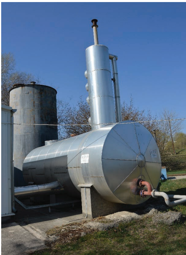
3. kép. A kitermelt termálvíz belép a gáztalanítóba, majd „belefollyik” a tárolótartályba. (Háttérben a visszasajtolásra kerülő, lehűlt termálvíz puffer tároló tartálya.)
