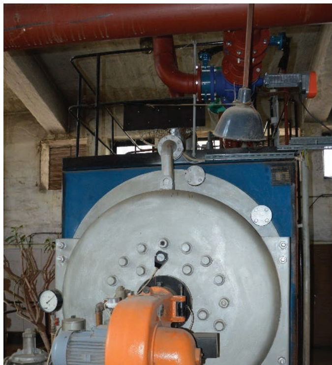
6. kép. Melegvíz kazánok szükség szerint melegítik a termálvízzel felmelegített fűtési melegvizet
