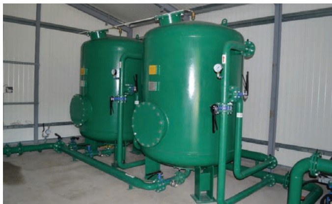
4. kép. A kitermelt termálvizet szűrőtartályokon nyomják át a szivattyúk
