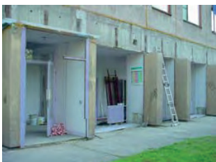
A földszinti nyílászárók bontása
