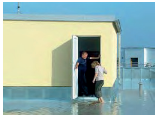
A csapadékvíz szigetelés próbája elárasztással
