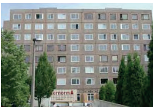
Az északi homlokzat részleges ablakcserével
