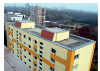
A felújított tető madártávlatból
