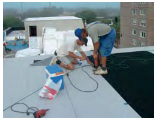
A liftgépház csapadékvíz-szigetelésének készítése
