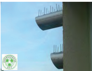
A homlokzati beszívó és kifúvó csanakok
