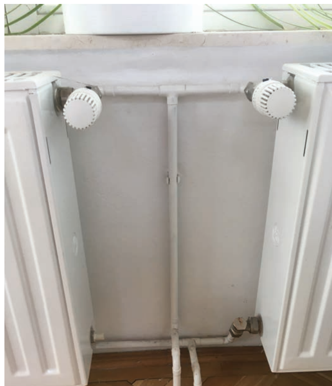
5. fénykép. A termosztatikus radiátorszelepek
