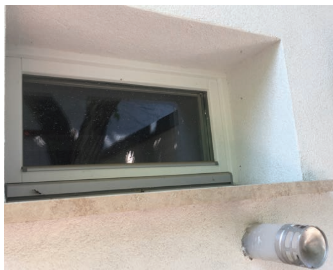
2. fénykép. Az égési levegő bevezetése
