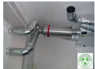
A konyhai elszívás kialakítása (burkolat nélkül)
