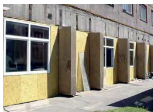
Az új földszinti fal a hőszigetelés előtt
