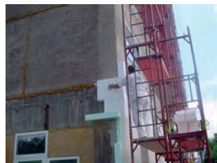
Indul a lakószintű hőszigetelés
