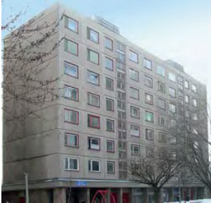
Az északi és keleti homlokzat felújítás előtt
