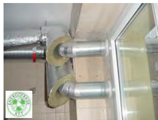
Ásványgyapot szigetelés a légszatórnákon
