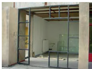
Zártszelvény acél szerkezet a falnyílásban
