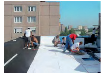
Az AUSTROTHERM hőszigetelő táblák fektetése
