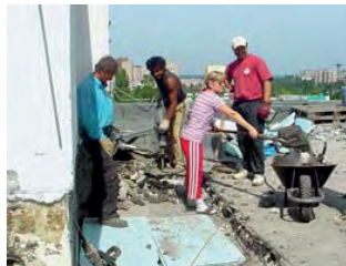
A régi tetőszigetelő rétegek bontása
