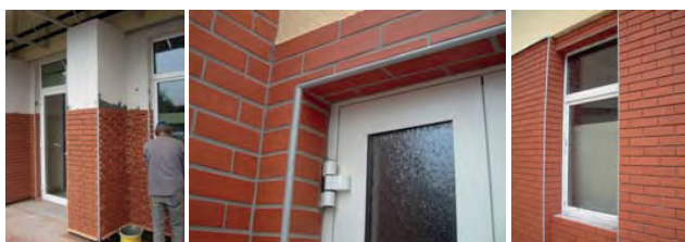
Zártszelvény acél szerkezet a falnyílásban
