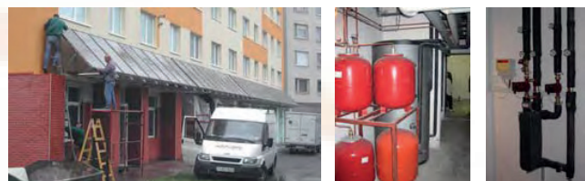
A kollektorok szerelése és a gépészeti berendezések
