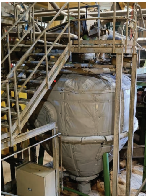
1. ábra. Hőkezelő „kanon” készülék szigetelés utáni fényképfelvétele
